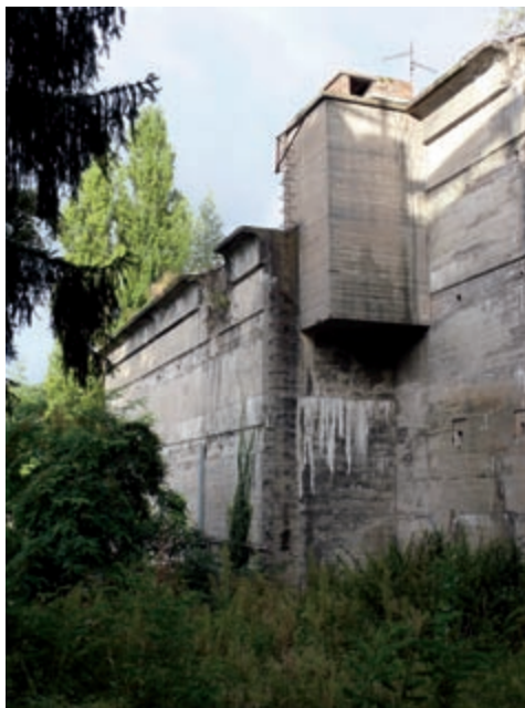
Der Bunker in der Rütscher Straße – Gefechtsstand von Oberst Wilck und Schauplatz der letzten Kämpfe um Aachen
